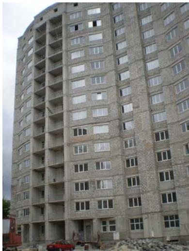
**Рисунок 9. Применение перлитобетонных стеновых блоков (Украина)**
