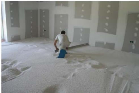
**Рисунок 3. Применение засыпной перлитовой изоляции (Германия)**
