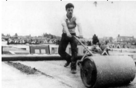
**Рисунок 4. Применение битумоперлита (США)**
