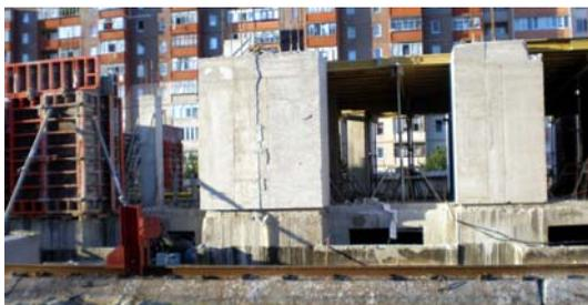
Рисунок 7. Стены из монолитного перлитобетона (Украина)
