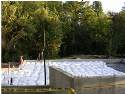
**Рисунок 2. Перлит в мешках для создания тёплых подготовок под полы на грунте**
