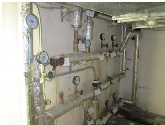
**Рисунок 2. Приборы контроля работоспособности калорифера (термометры, манометры)**
