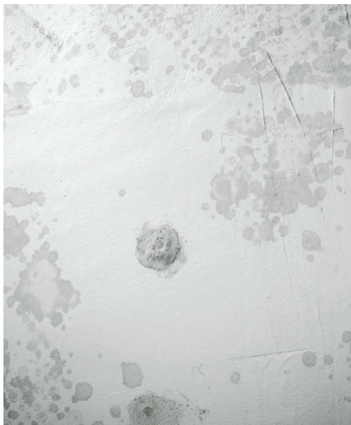
Рисунок 3. Оцениваемая конструкция после испытаний
