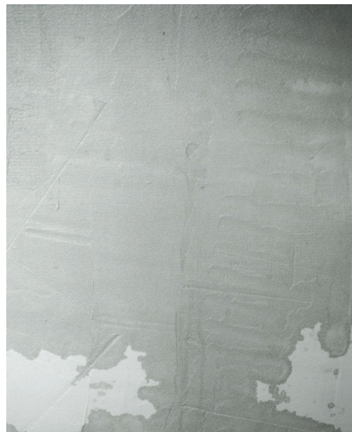
Рисунок 4. Базовая конструкция после испытаний
