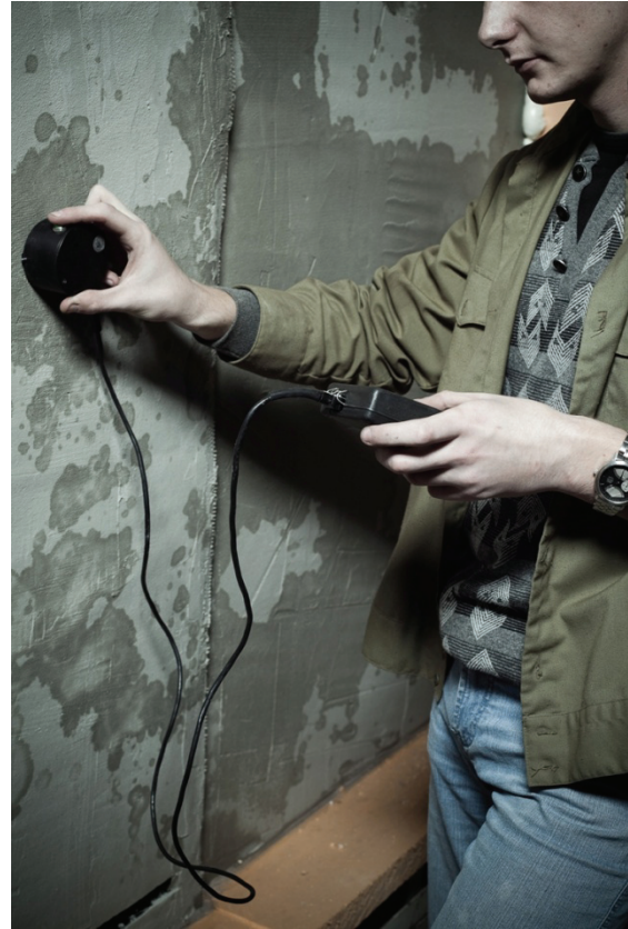
Рисунок 2. Измерение влажности штукатурного слоя прибором ИТП МГ4 «Поток»
