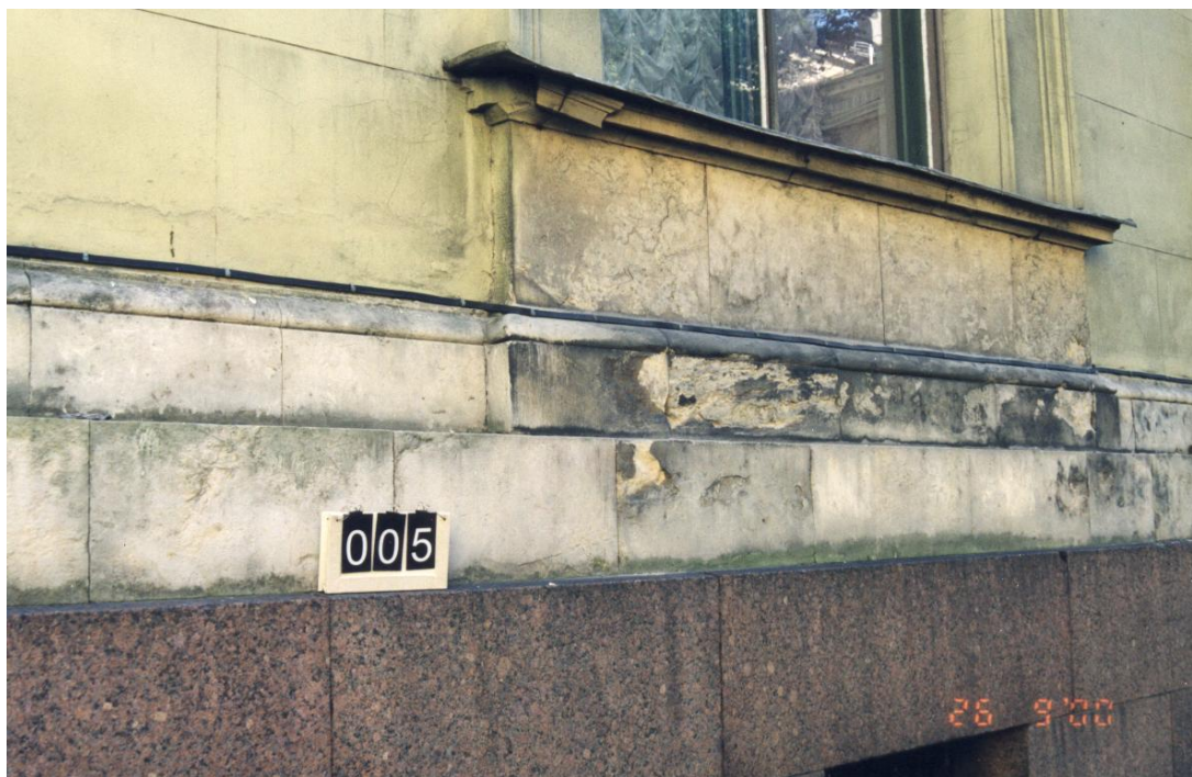
Рисунок 3. Биоповреждение природного камня
