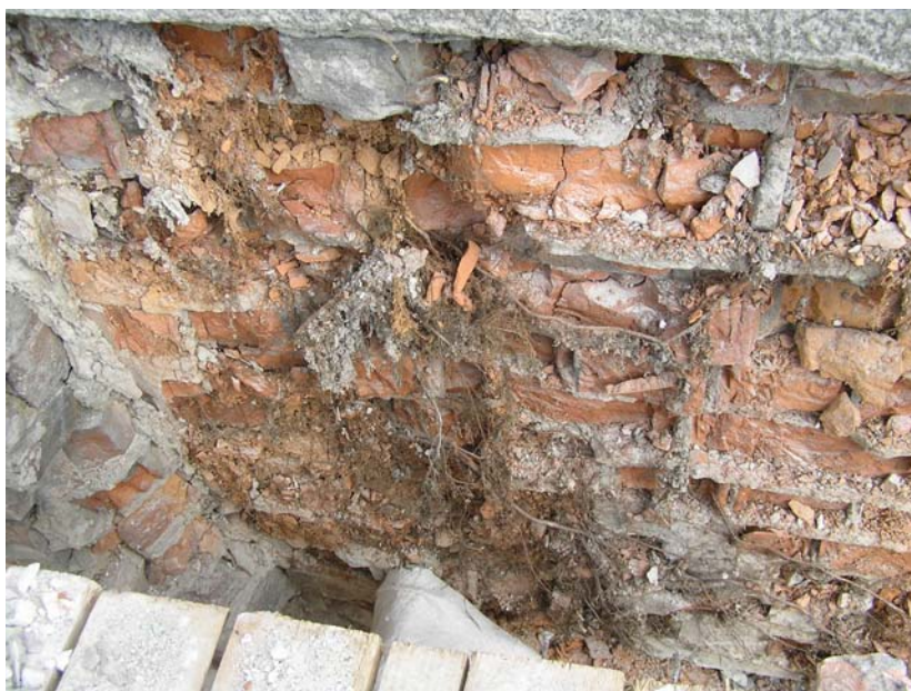
Рисунок 9. Разрушение кирпичной кладки корнями самосеянного дерева
