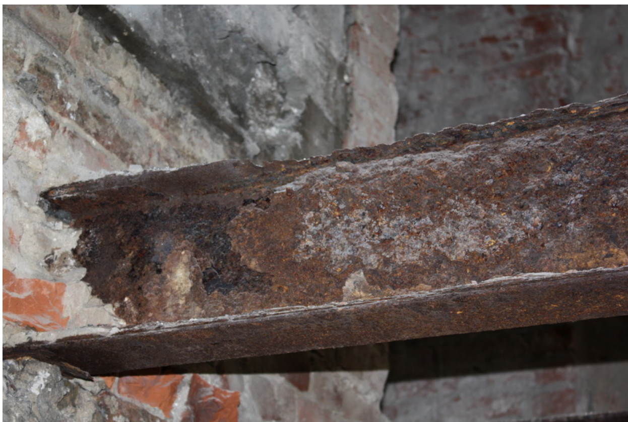
Рисунок 7. Биоповреждение стальной балки
