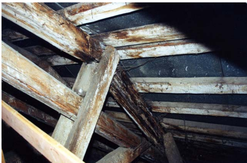
Рисунок 10. Разрушение деревянных конструкций домовыми грибами
