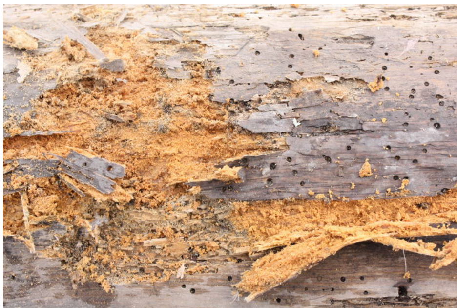
Рисунок 11. Разрушение деревянных конструкций жуками
