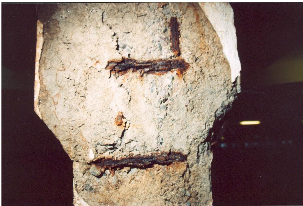
Рисунок 2. Разрушение оголовка железобетонной колонны в результате жизнедеятельности микроорганизмов
