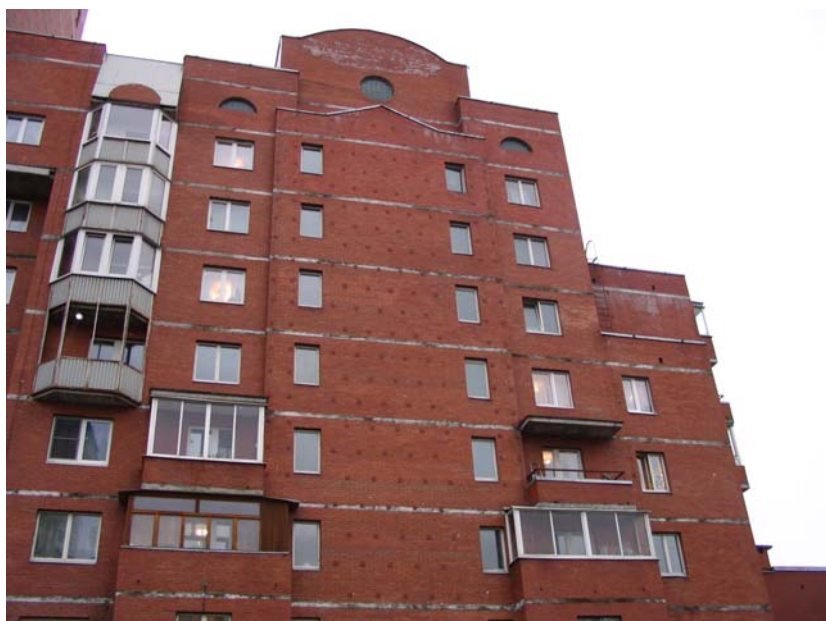
Рисунок 6. Наглядное состояние объекта с многочисленными дефектами кирпичной кладки в отделочном слое: высолы, замокания в местах выступающих плит, отсутствие связи отделочного слоя (дополнительные крепления)
