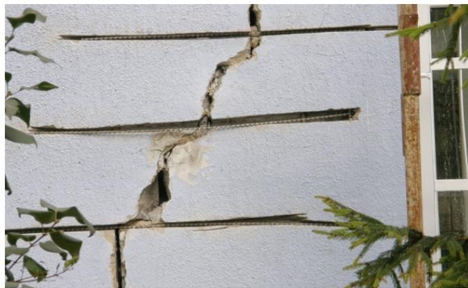
Рисунок 8. Усиление наружных стен, поврежденных трещинами
