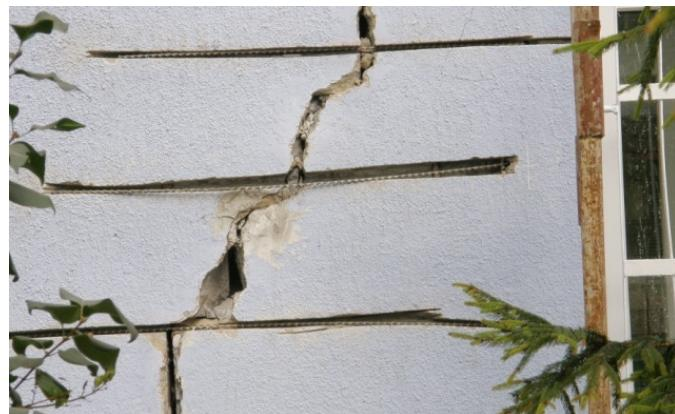
**Рисунок 8. Усиление наружных стен, поврежденных трещинами**
